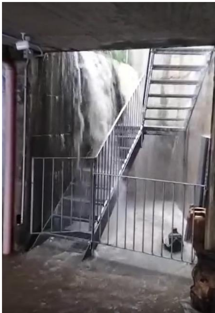
FIGURA 7 – AUTORIMESSE ALLAGATE PER ROTTURA DELLA TUBAZIONE
